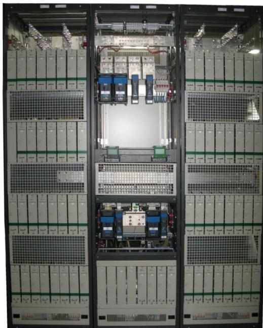
Рисунок 7.2 - ЭПУ в составе двух стоек СУЭП-3 и ЩТР
